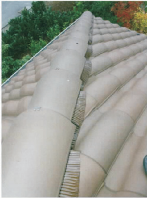
Passende Formteile und Zubehör an First und Grat schließen das Dach nach oben nahtlos ab.
